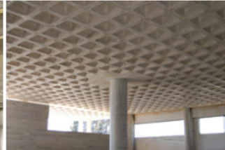
شكل (6) نظام ثنائي الاجهاد في العنصر الواحد (تحت تأثير العزوم) Bulk Active Structural نظم الكمرات والاطارات.
