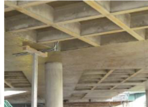
شكل (6) نظام ثنائي الاجهاد في العنصر الواحد (تحت تأثير العزوم) Bulk Active Structural نظم الكمرات والاطارات.
